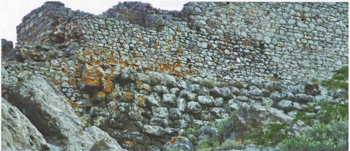
Βυζαντινά/Ενετικά τείχη κτισμένα επάνω σε Κυκλώπεια τείχη στη Βόρεια πλευρά του κάστρου
