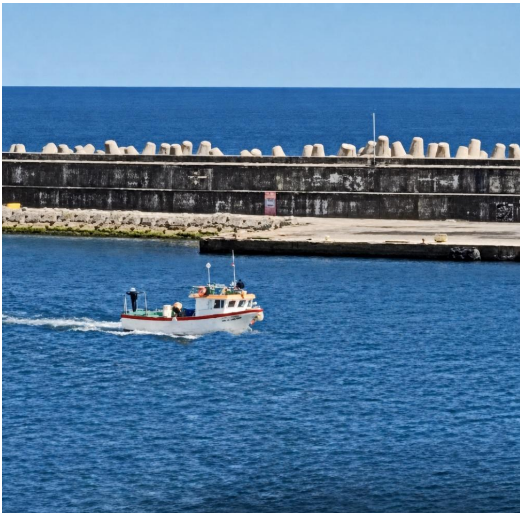
Ponta Delgada, Προστατευτικός Τοίχος 12 μέτρων
